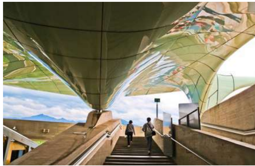
FUTURISTISCH geht es nach oben aufs Hochplateau. Ausstieg der Hungerburgbahn, entworfen von der Star-Architektin Zaha Hadid.
